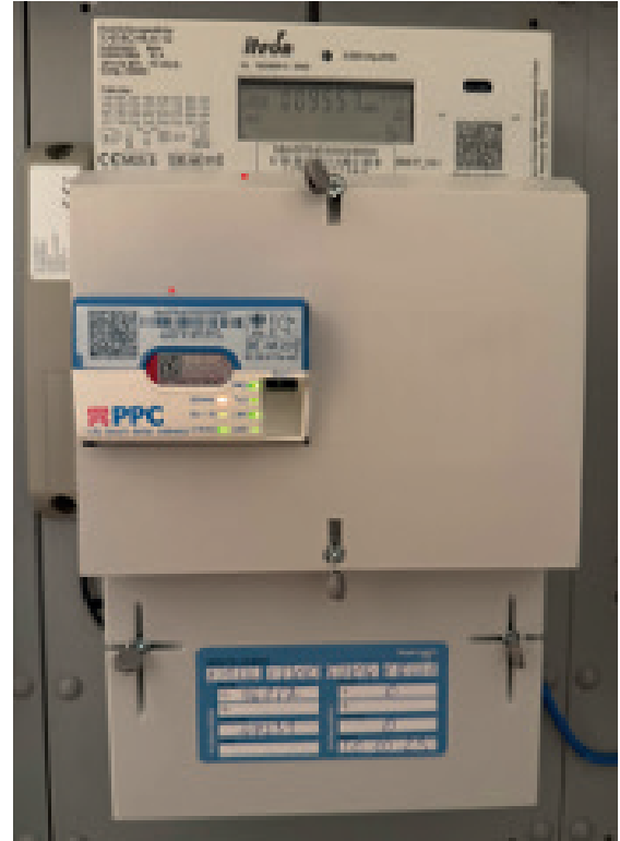
Moderner Zähler mit Smart Meter
